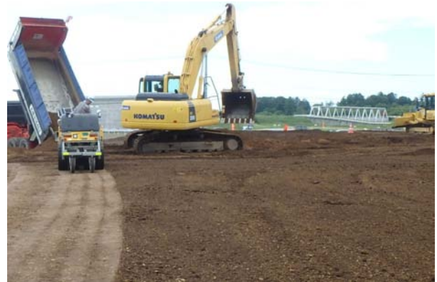
図-11 整地状態での転圧
