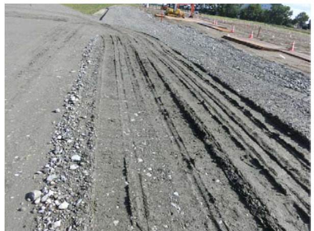
図-7 タイヤローラー走行跡
