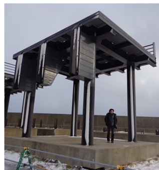
写真-1 鋼製栈橋
