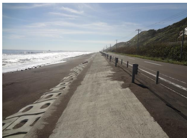
写真-1 現地における緩傾斜護岸の状況
