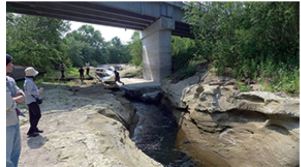
図-1 軟岩の浸食により橋脚の基礎が露出した例
