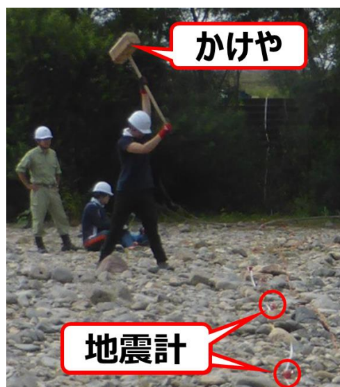
図-3 陸域での表面波探査の実施状況
