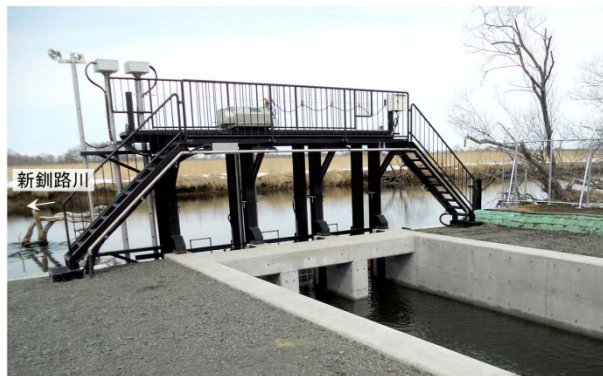
写真-1 愛国浄水場取水口（河口から8.8 km）
