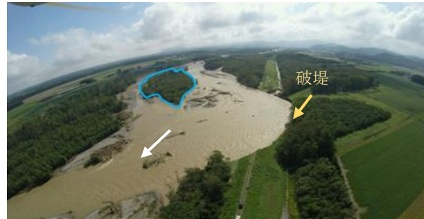
図-3 2016 年出水後のドローン写真、中洲の樹林帯を青枠で示す（(株)北開発水工コンサルタント）
