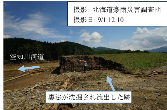
図-7 決壊口上流側の様子
