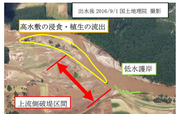
図-6 上流側破堤地点の高水敷と植生の流出
