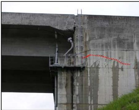
写真-1 桁衝突による橋台損傷事例
