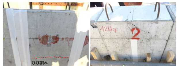
(a) 擁壁背面(重錘衝突面) (b) 擁壁前面および上面
