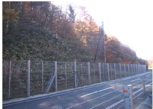
写真-1 従来型落石防護柵
