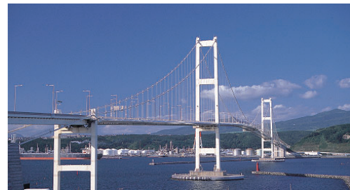
写真-1 白鳥大橋の全景
