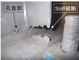
写真-5 不陸調整前
