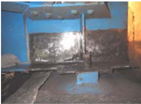
写真-3 下地処理後
