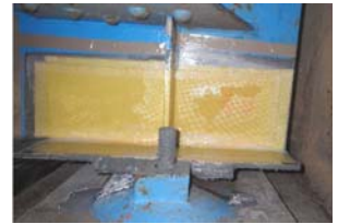
写真-7 シート貼付け完了
