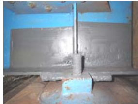
写真-4 防錆処理後
