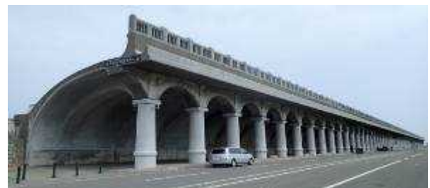
図-1 北防波堤ドーム全景
