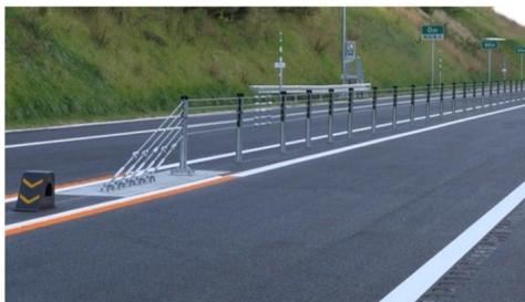
写真-2 ワイヤーロープ式防護柵端末部
