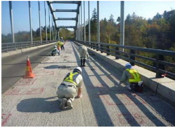
写真-3 実橋における試験状況
