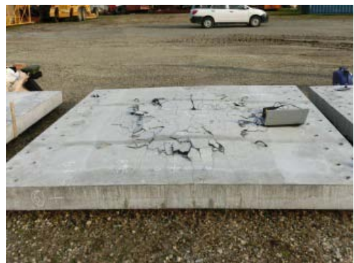
写真-2 供試体全景（劣化部）
