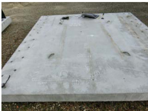
写真-1 供試体全景（健全部）
