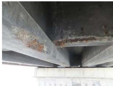
写真-1 海岸部道路橋の鉄筋露出状況
