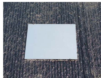
写真-3 アルミ板の設置状況
