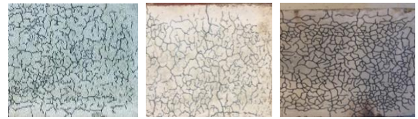
(a) 普通セメント(日本) (b) 早強セメント(日本) (c) 普通セメント(タイ)
