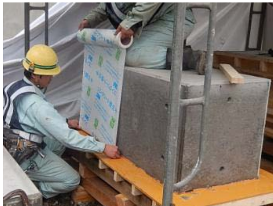
写真-2 保水養生テープ施工状況
