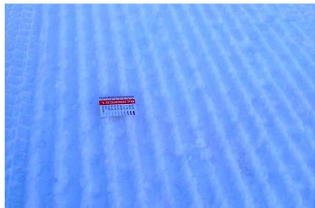
写真-6 雪氷路面処理装置施工後のアイスバーン
