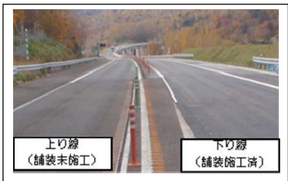
写真-3 施工境のすりつけ状況
