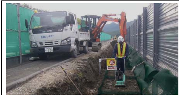
写真-2 固定路肩規制内の施工状況
