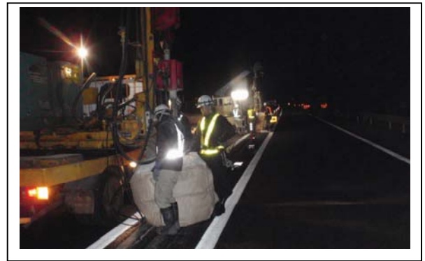
写真-4 防護柵支柱設置 (岩削工) 施工状況
