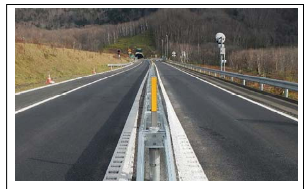
写真-5 分離2車線構造完成状況
