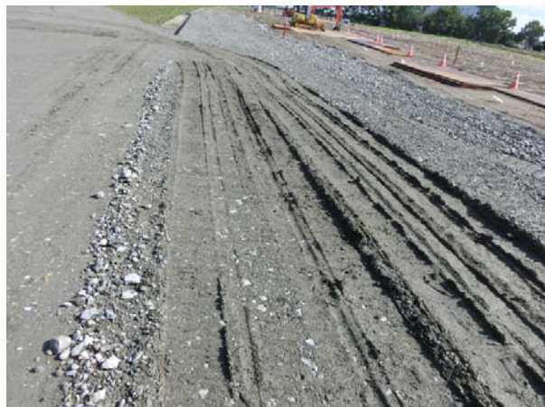
図-10 タイヤローラー走行跡
