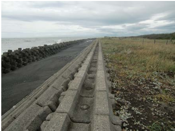
写真-1 沙流側西側(1)の苫小牧側
