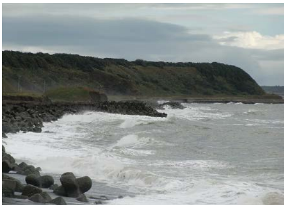
写真-2 沙流側西側(1)のえりも側
