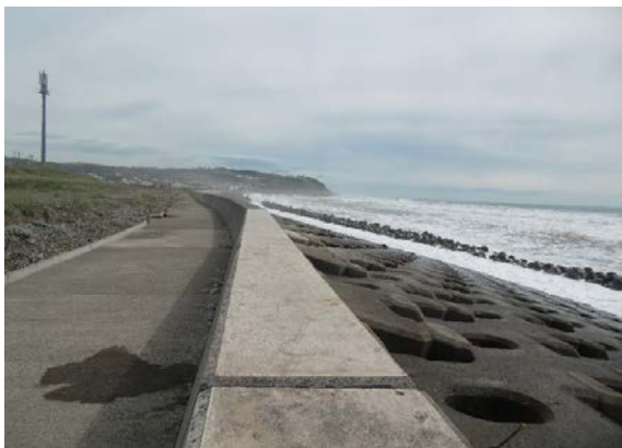
写真-8 新冠川東側(4)のえりも側
