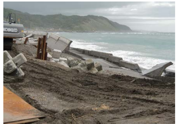
写真-10 JR 春立駅付近(5)のえりも側
