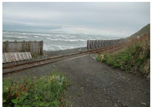
写真-6 JR 大狩部駅付近(3)の苫小牧側
