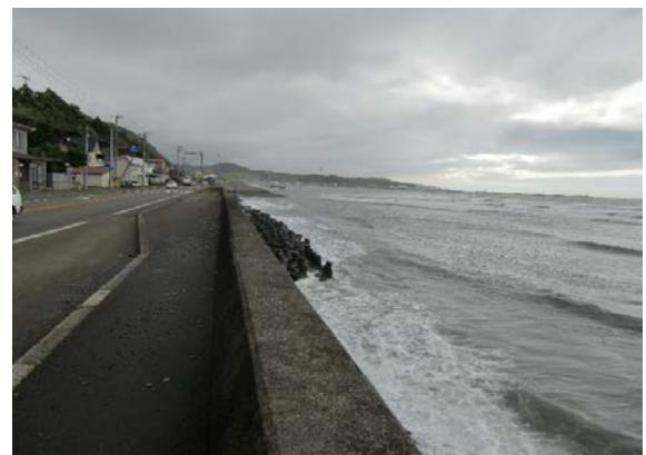
写真-12 浦河町井寒台(6)のえりも側
