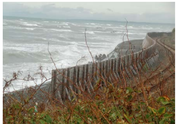
写真-5 JR 大狩部駅付近(3)の苫小牧側
