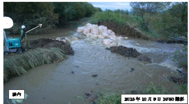
図-16 堤内側から見た16時50分ごろの復旧状況
