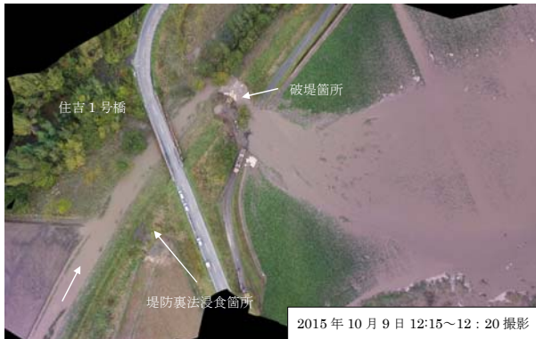
図-5 サラカオーマキキン川における破堤近傍の上空から撮影した状況
