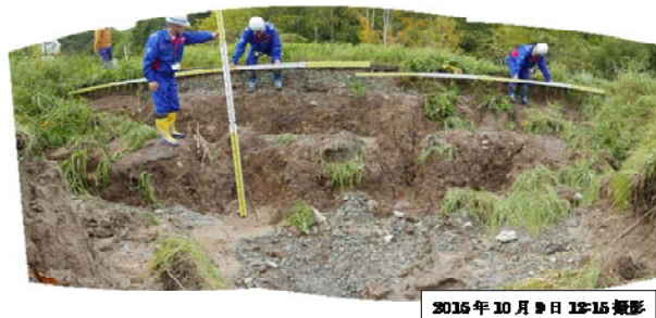
図-7 サラカオーマキキン川上流側堤防裏法浸食状況
