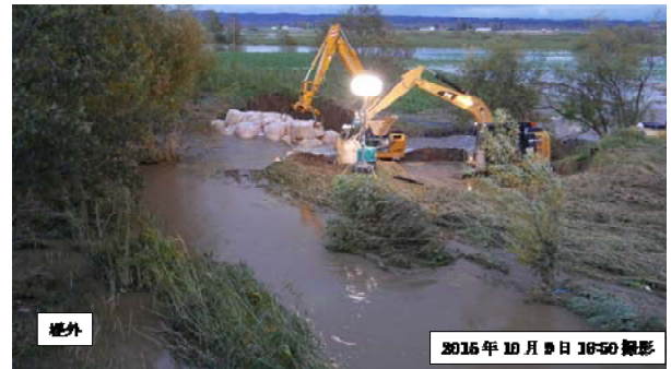
図-15 堤外側から見た16時50分ごろの復旧状況
