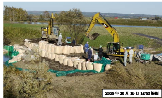
図-18 10月10日における復旧状況
