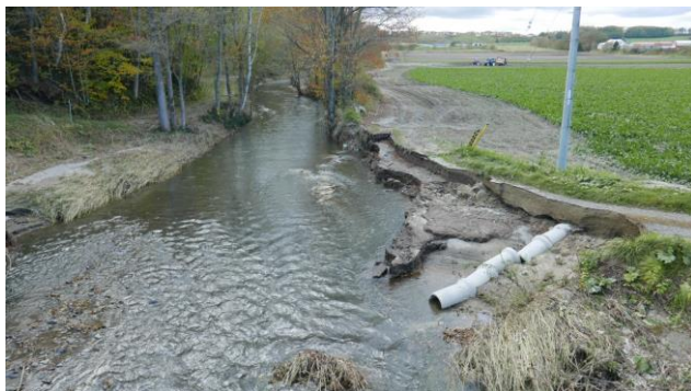
図-10 藻琴橋の直上流部の状況
