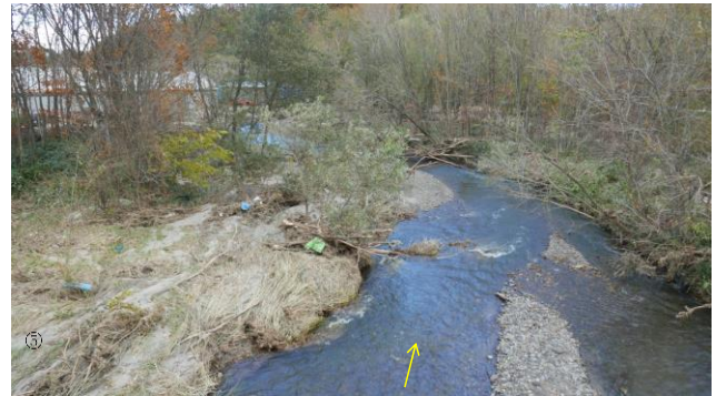
図-11 藻琴橋の直下流部の状況
