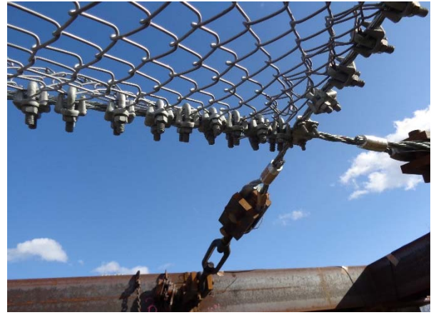
写真-5 実験終了後の金網固定状況
