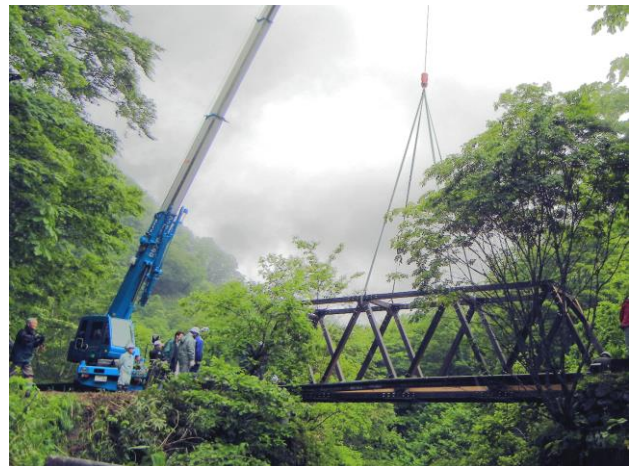
写真-3 登山道への架設(第3回目)
