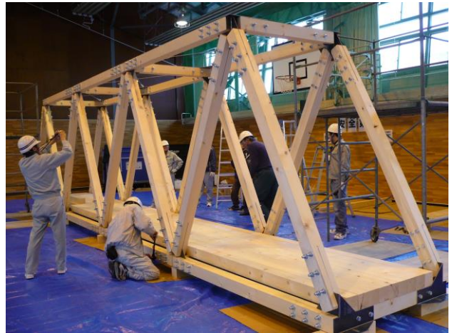
写真-1 体育館での架設(第1回目)
