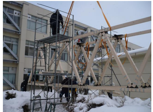
写真-2 校内敷地での架設(第2回目)
