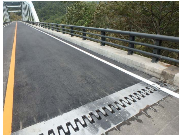
写真-3 段差擦り付け後の伸縮装置付近の状況
