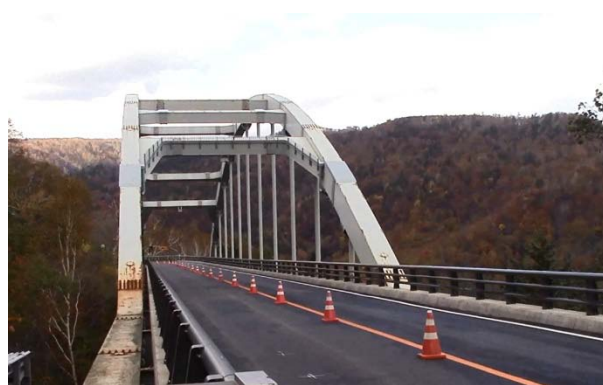
写真-1 対象橋梁全景
