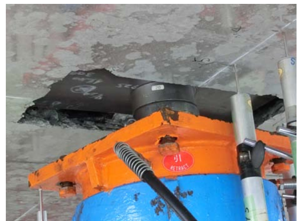
図-11 荷重板の押し抜き状況
