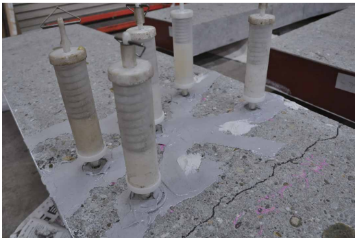
写真-1 ひび割れ注入の状況
