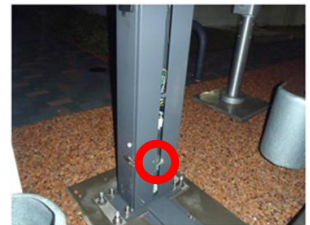
写真-4 ETCセンサーへの 付着状況
