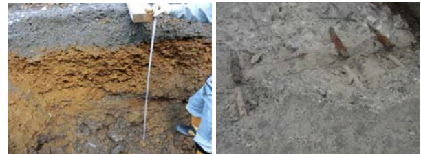
写真-5 舗装断面(増毛地区) 写真-6 ダウエルバーの破断
