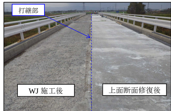
写真-5 床版上面断面修復の状況
