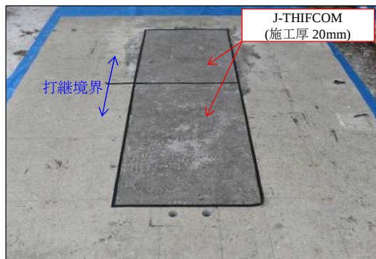
写真-3 輪荷重走行試験後の供試体面上面状況
