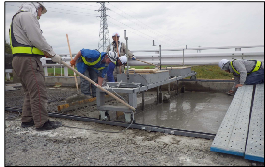
写真-4 J-THIFCOM 打設状況
