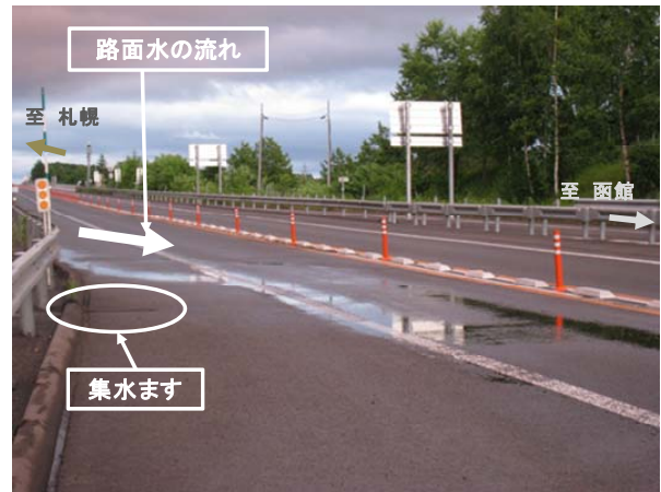
写真-2 滞水状況
