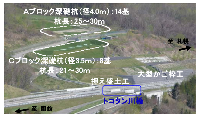
写真-5 本対策工
