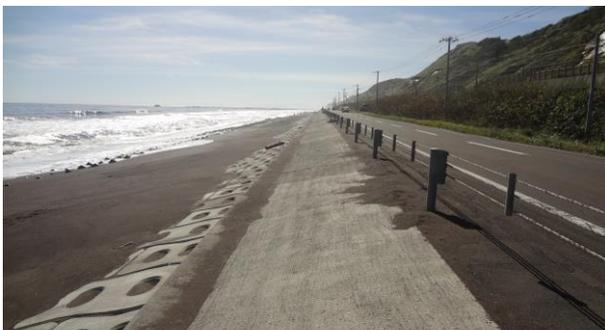
写真-1 現地における緩傾斜護岸の状況
