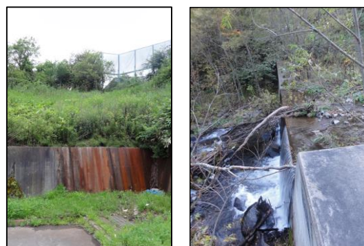
写真-1 水元沢川の落差(左)と鷺別川砂防ダム(右)
