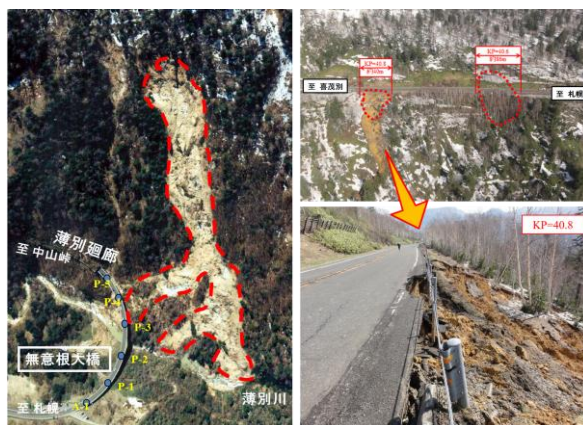
写真-1 国道 230 号中山峠の被災状況
