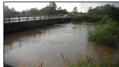
写真-2 ウヨロ川道道橋の状況 (2014/09/10 8:18)
