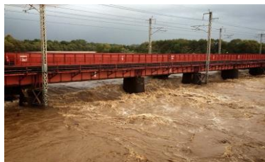
写真-1 敷生川鉄道橋の状況 (2014/09/10 10:40)
