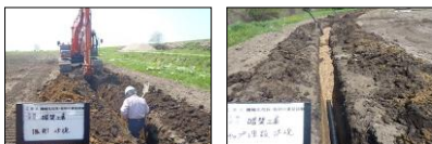
写-7 暗渠疎水材の施工
