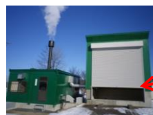
写-4 チップボイラー
