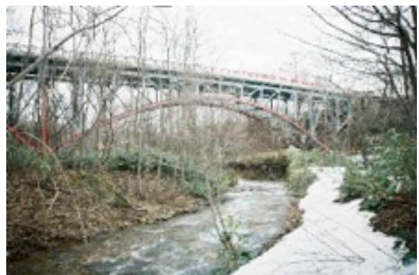
写真1 バランスド・アーチを採用した張碓橋
