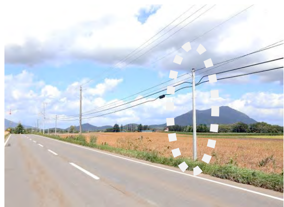
写真－3 通信線の増加に伴い既存電柱の間に通信用の電柱が増設された事例
