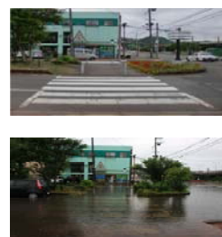
写真-1 冠水時の最大被害箇所の様子 8)
