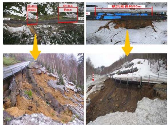
写真-1 国道 230 号線中山峠の被災状況
