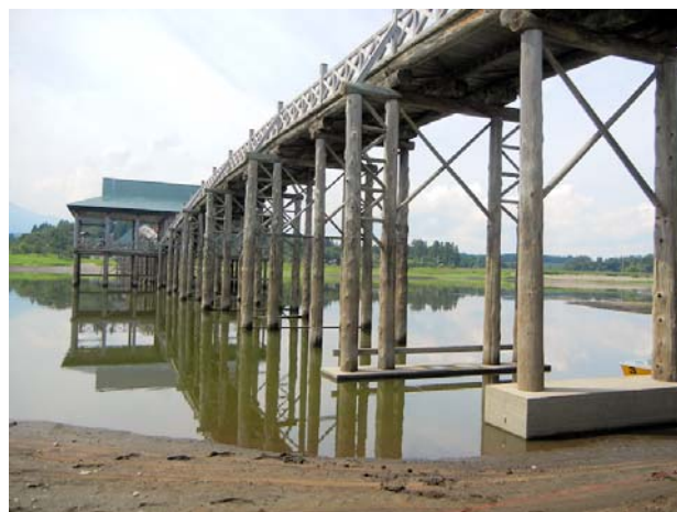
写真-2 柱頂部と柱基部
