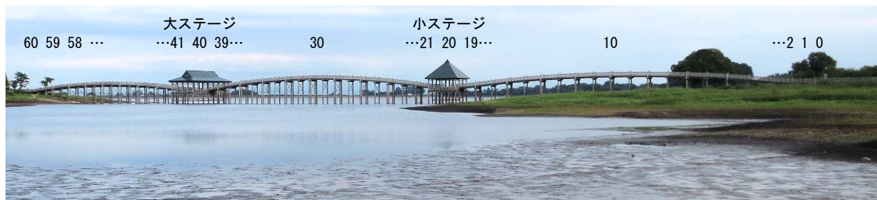
写真-1 鶴の舞橋の全景と橋脚番号
