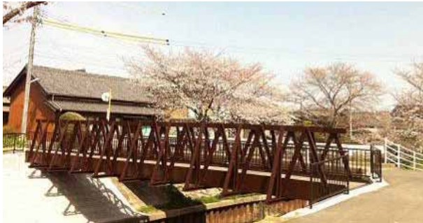
図-1 玄若橋（FRP 歩道橋）
