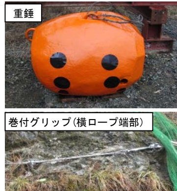
写真-2 重錘・巻付グリップ・アンカー破断状況
