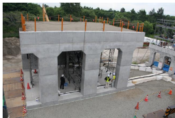
写真-1 実 RC 製ロックシェット試験体
