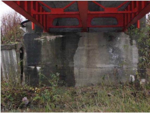
写真-1 橋梁dの2007年点検時 A1 躯体
