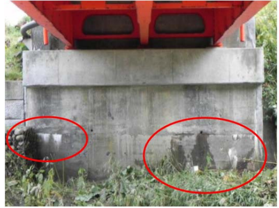
写真-2 橋梁dの2012年点検時 A1 躯体
