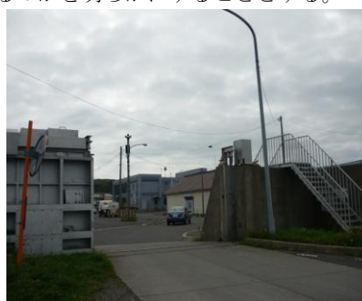
図-1 浜中町市街地をとり囲む防潮堤
